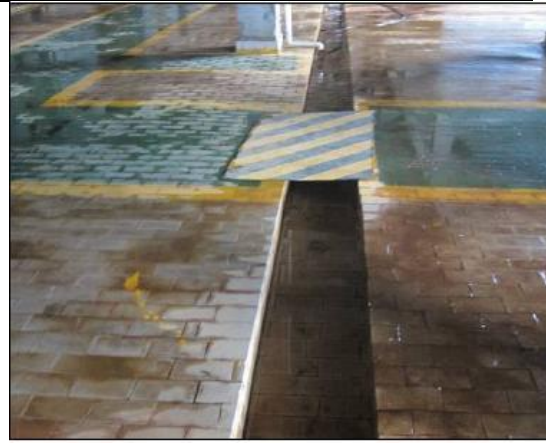
搅拌浸出车间地表防渗
