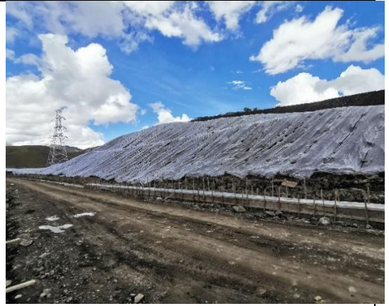
1#弃土场绿化及排水沟施工
