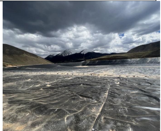
觉达玛弄排土场淋溶水收集池
