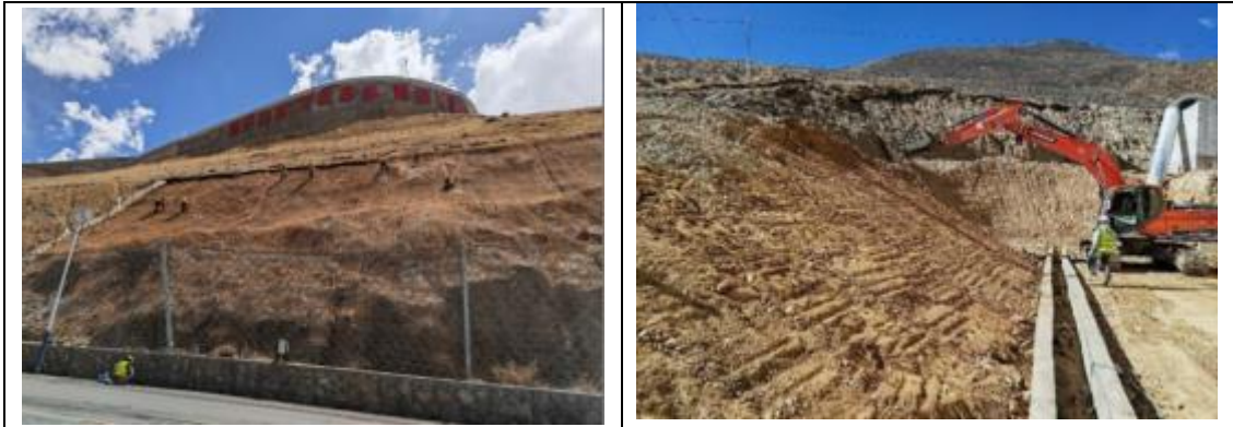
生态恢复现场施工照片
