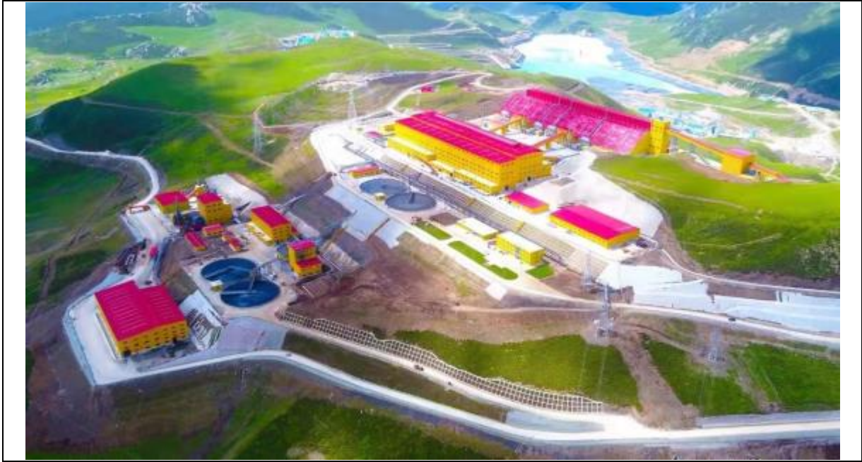
三选厂（选矿一车间）工业场地全貌
