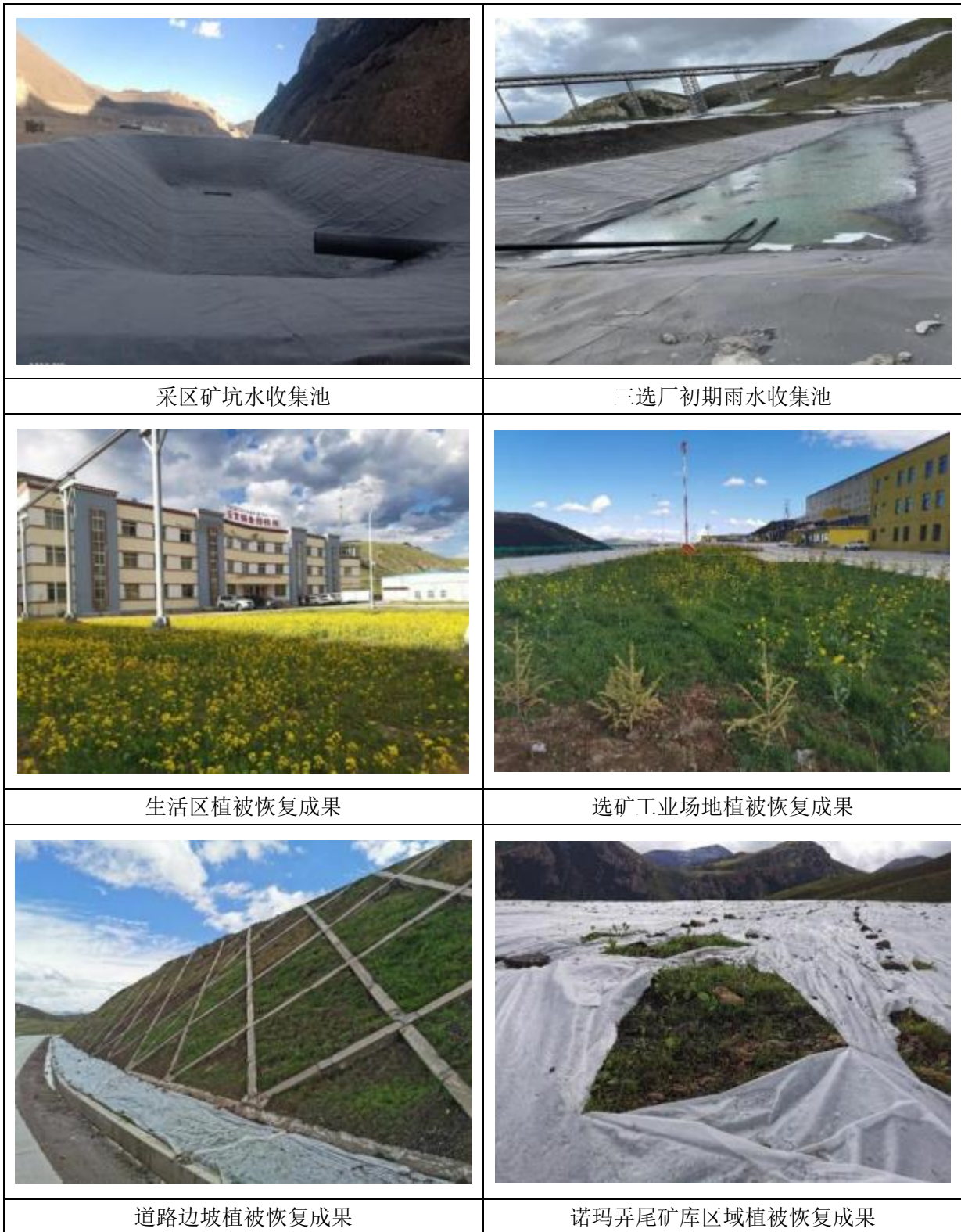
图 3.9-1 现有工程环保设施照片
