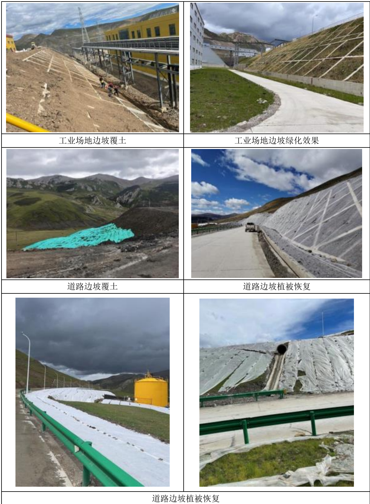
图 3.9-2 现有工程生态修复现状照片
