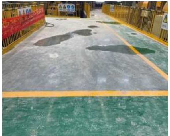
选矿车间防渗工程
