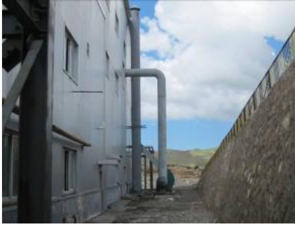
石灰乳制备车间排气筒
