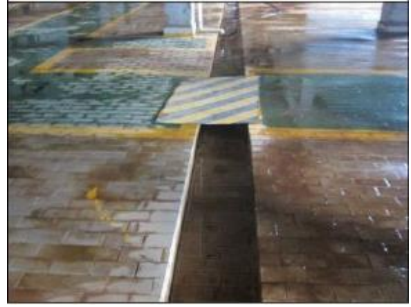
搅拌浸出车间地表防渗
