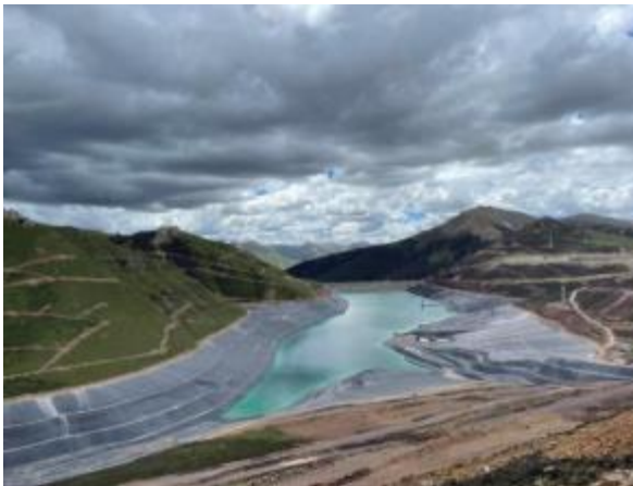
尾矿库全防渗
