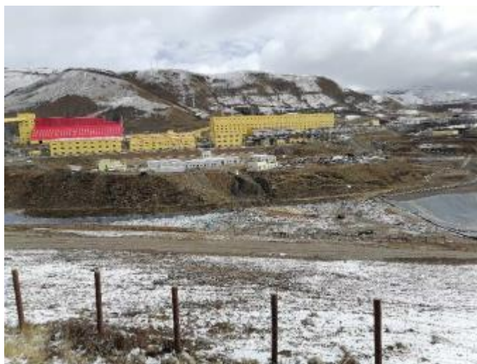
生活垃圾填埋池
